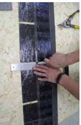
Рис. 7. Деление плитки на лепестки
